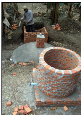
Construction d'un digesteur à biogaz
